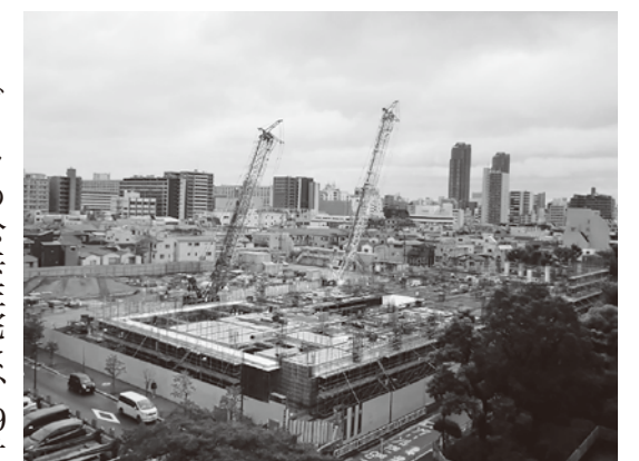
工事中の二大中の様子
